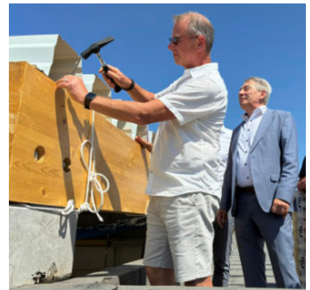
Bauhofchef Mario Otto beim Einschlagen des letzten Nagels ins Gebäk
