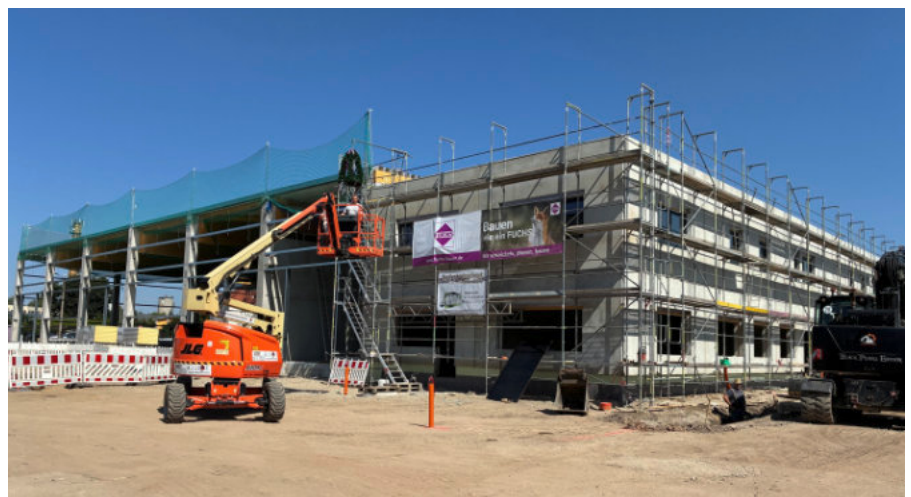
Das Dach ist drauf: Die Richtkrone symbolisiert die Fertigstellung des Rohbaus
