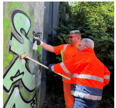
Bauhofmitarbeiter Andreas Thiele und Oberbürgermeister Tim Lochner am Fluttor Klosterstraße
