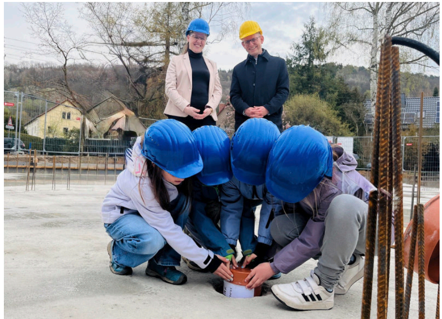
Schulkinder lassen im Beisein von Schulleiterin Silvia Janak und Bürgermeister Markus Dreßler die Zeitkapsel im Gebäudefundament ein (Foto: Stadtverwaltung)
