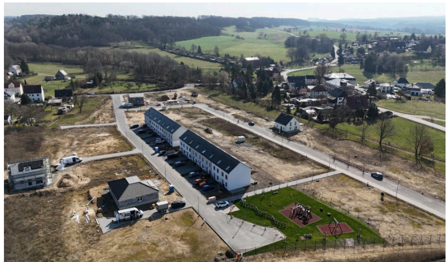
Aktueller Baustand des Wohngebietes im März 2026
