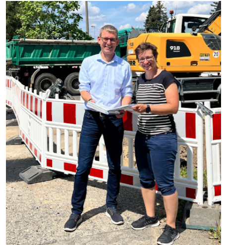
Bürgermeister Markus Dreßler und Sandra Roscher, Fachgruppenleiterin Tiefbau, an der Baustelle Struppener Straße (Fotos: Stadtverwaltung)
