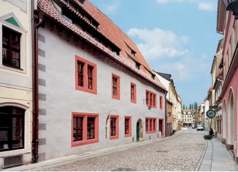
Das Tetzehaus in der Pirnaer Schmiedestraße
