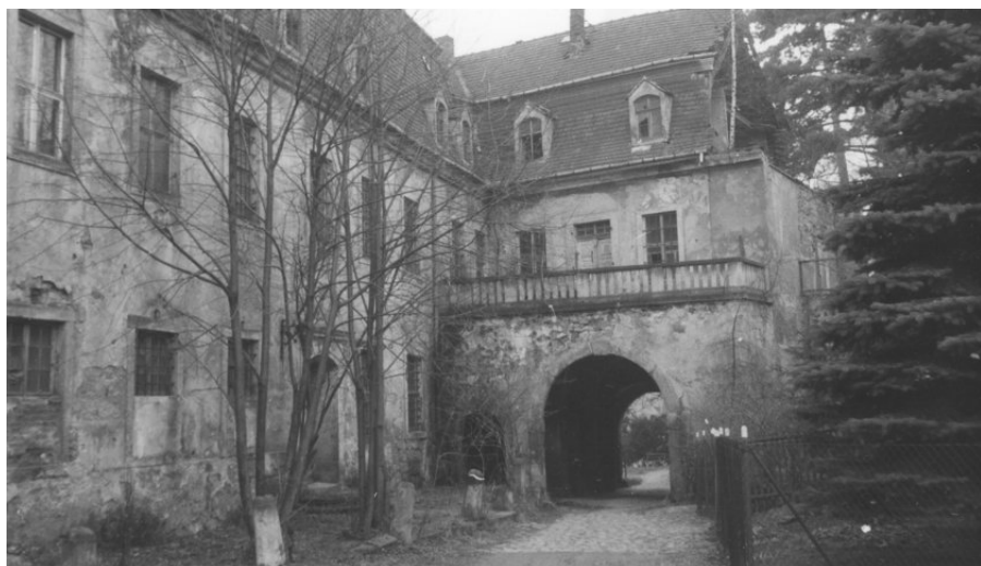
Zustand des Landschlusses Zuschendorf zur Zeit des Erwerbs im Jahre 1988 (Foto: Michael Rühle)
