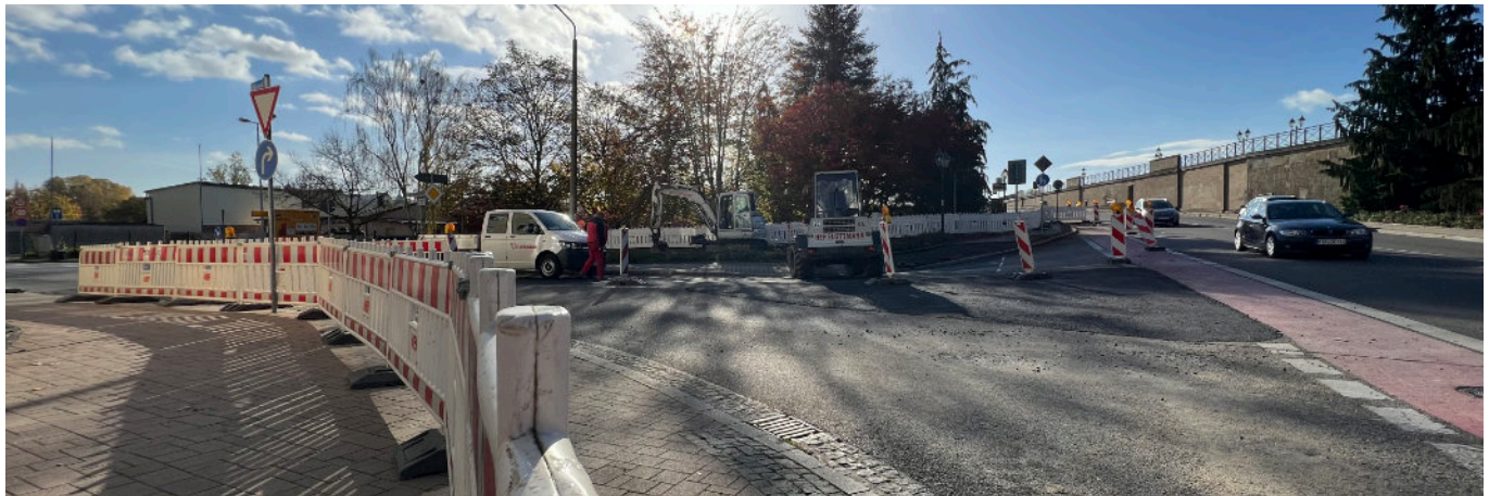
Bauarbeiten an der Kreuzung Stadtbrücke/Hauptstraße/Fährstraße (Foto: Stadtverwaltung)
