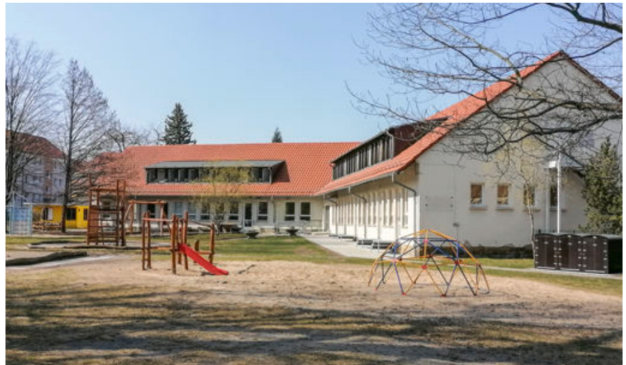
Neue Außenstelle der Kita Schlängelbachweg (Foto: AWO)
